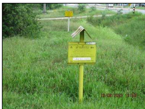
รูปที่ 2-35 การแจ้งเหตุที่แนวท่อส่งก๊าซ ต้องแสดงสัญลักษณ์ด้วยป้ายสีเหลืองที่สามารถสังเกตเห็นได้ชัดเจน
